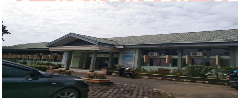
Gambar 2.2 Lapangan depan dan ruang kantor
