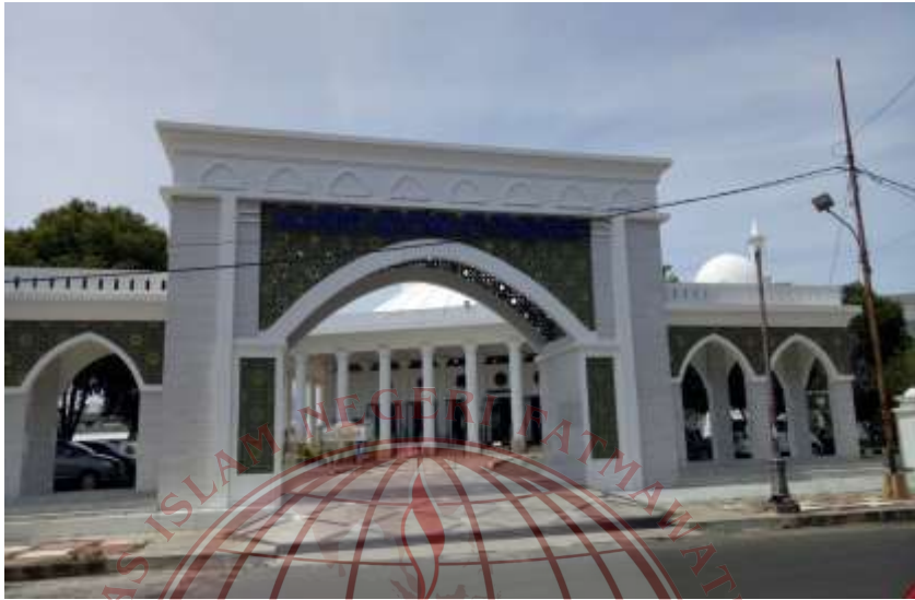
Gambar.11 Kondisi pagar masjid Agung At-Taqwa setelah di renovasi 11 September 2022. Dokumentasi Penulis 2022
