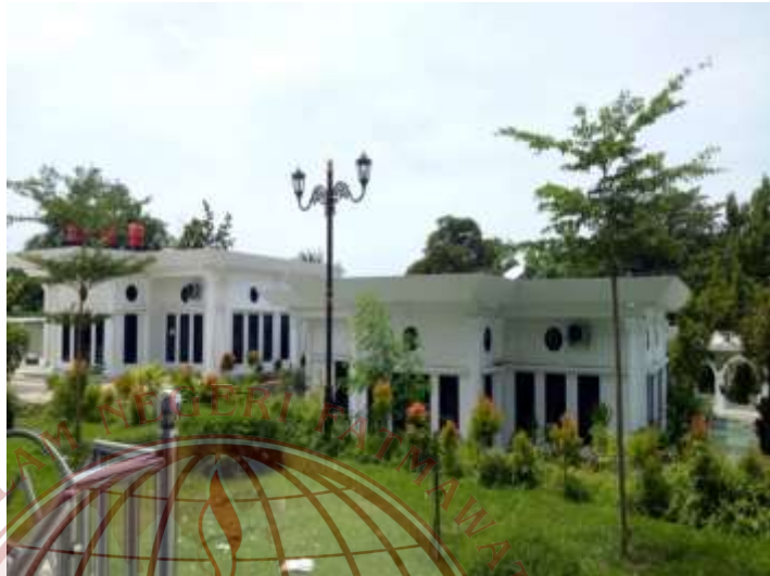
Gambar III.8 Kantor Wali Kota Bengkulu. Dokumentasi penulis 13 Oktober 2022
