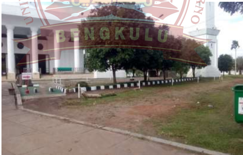
Gambar.12 Kondisi Area parkir sebelum di renovasi pada 2017. Dokumtasi Bapak Karsito 2017
