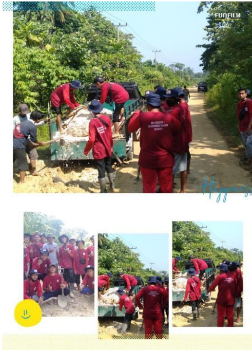
Gambar 5 Pelaksanaan Gotong Royong Perbaikan Jalan
