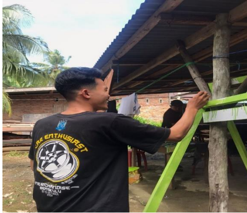
Gambar 30 Pembuatan dan Pengecatan Plang
