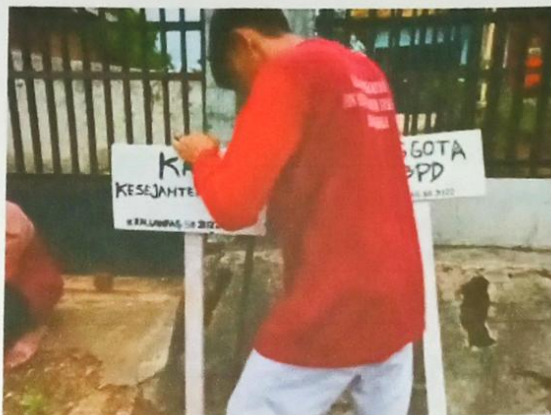
Gambar 31. Pemasangan Plang Papan Nama Perangkat
