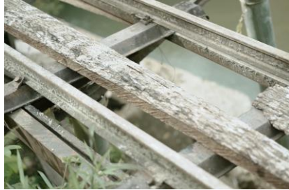
Gambar 6. Rel yang telah rusak dan ditambahkan kayu oleh warga yang mempergunakan rel.
