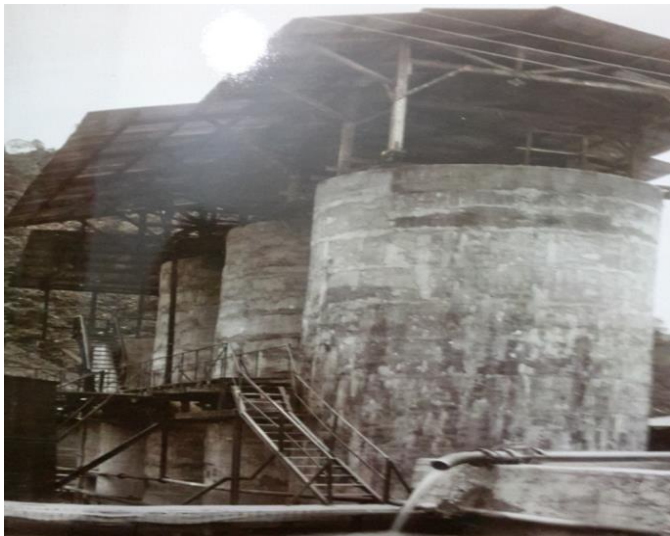
Gambar 1. Bangunan Silo pada Zaman Kolonial Belanda. Sumber: Dokumen Arsip Gerard de Graaf.
