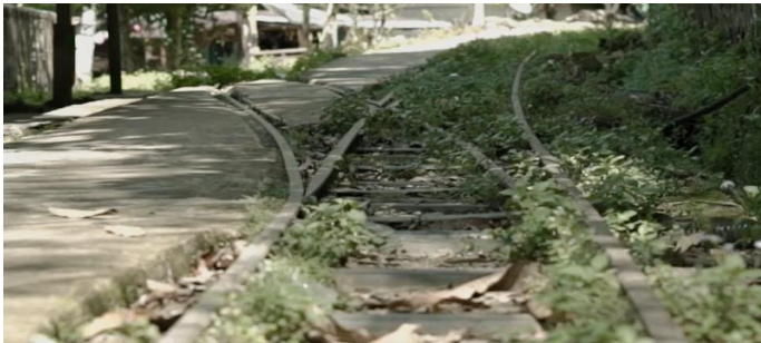
Gambar 5. Salah satu bagian rel yang memiliki cabang. (Sumber: Nadio, 10 April 2023)
