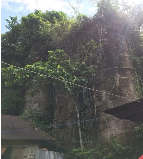
Gambar 2. Kondisi Bangunan Saat Ini. Sumber: Dokumentasi Peneliti Tahun 2023.
