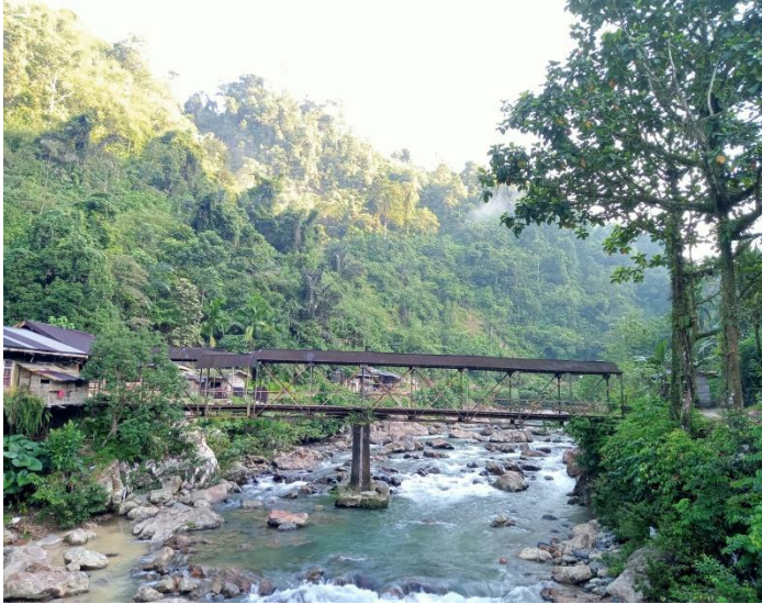
Gambar 6. Jembatan Simau dari sisi hilir sungai (Sumber: Dokumentasi Een Syaputra Tahun 2023)
