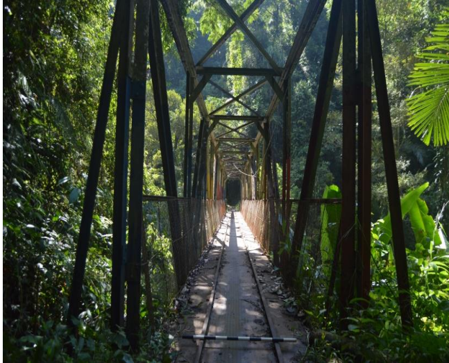
Gambar 3: Jembatan Glumbuk dipotret dari pertama masuk. (Sumber: Dokumentasi Peneliti Tahun 2023)
