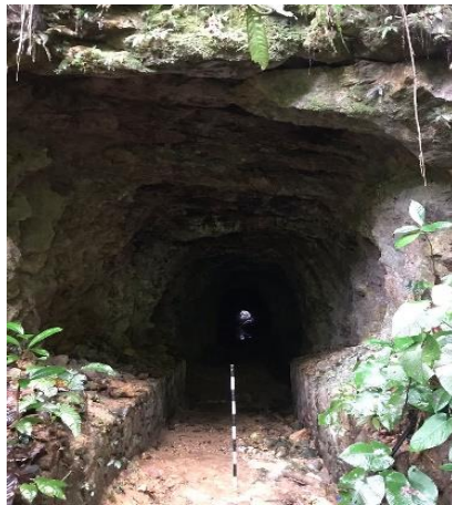
Gambar. Terowongan Kedua menuju Dam Toko Rotan. Sumber: Dokumentasi Peneliti Tahun 2023.
