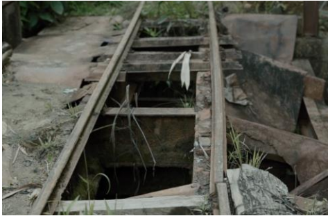
Gambar 3. Jalur rel yang terdiri atas tiga struktur rel, yakni rel, fastening , dan sleeper .
