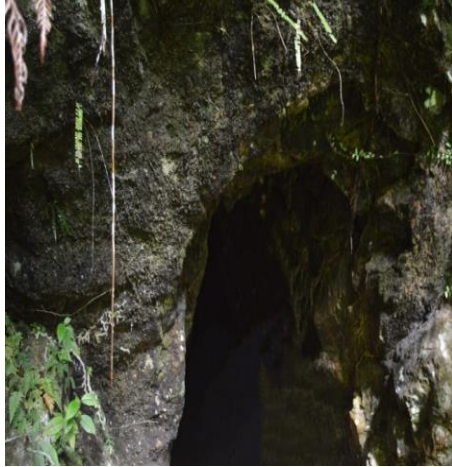
Gambar. Terowongan Pertama menuju Dam Toko Rotan. Sumber: Dokumentasi Peneliti Tahun 2023.
