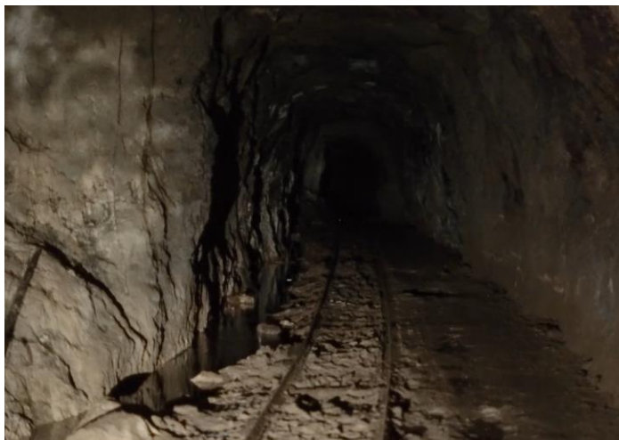
Gambar 8. Bagian rel yang melalui mulut goa dan sewaktu-waktu berada dalam kondisi terendam air.
