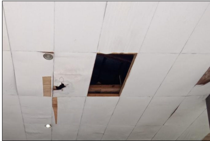
Gambar 4.2 Plafon Rumah Adat Kota Bengkulu
