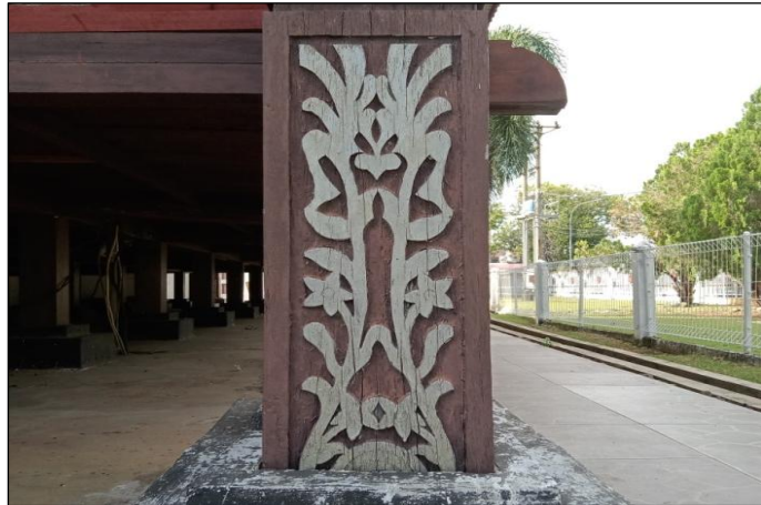
Gambar 4.10 Ornamen Pada Tiang Pondasi
