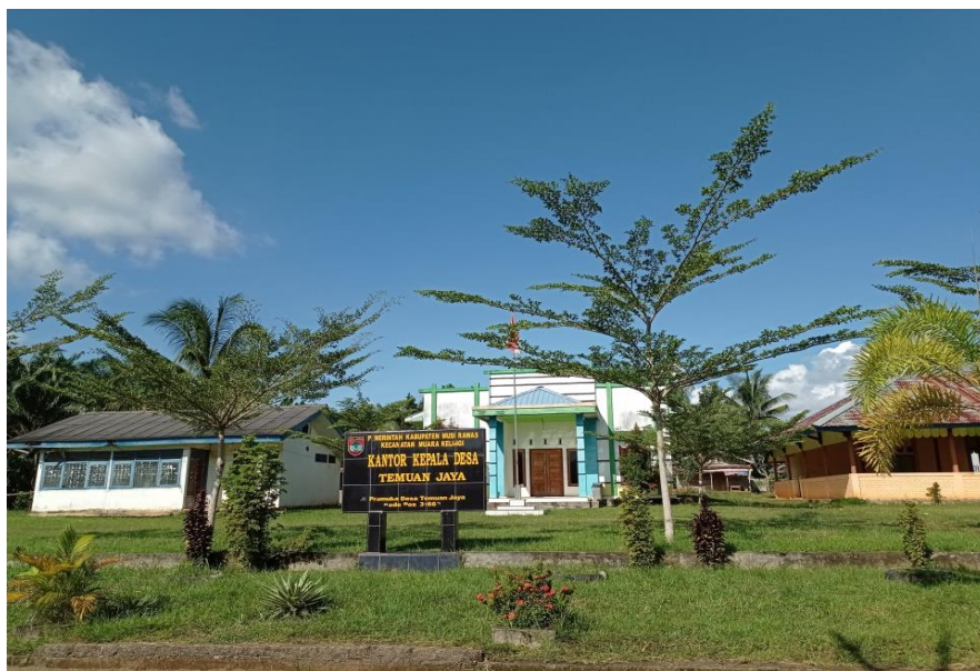
Foto Kantor Desa Temuan Jaya
