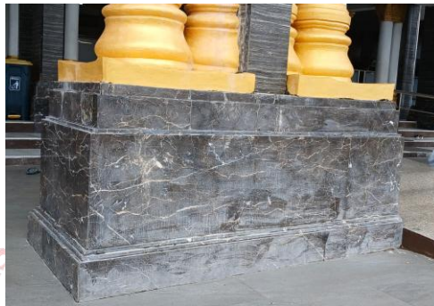
Gambar 2.5 Penyangga Tiang Masjid Raya Baitul Izzah Berbentuk Balok
