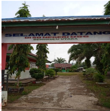
Foto bagian depan bangunan sekolah SDN 56 Kecamatan Napal Putih
