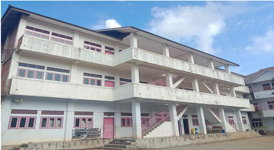
Gambar 1. Gedung Madrasah Tsanawiyah Ja-alHaq Kota Bengkulu
