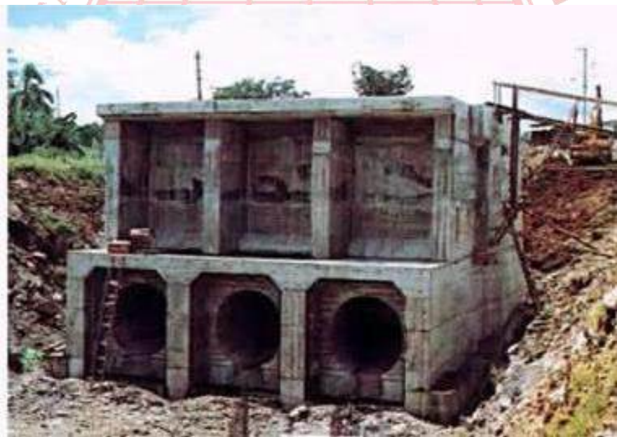
Pembangunan Pembangkit Listrik Tenaga Air (PLTA) Kabupaten Rejang Lebong Tahun 1988
