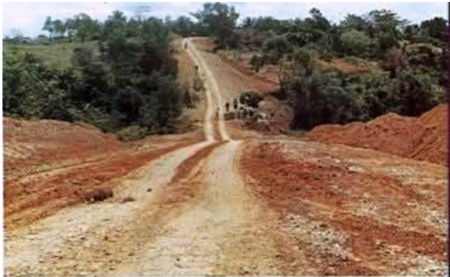
Peningkatan jalan menjadi kondisi mantap terutama pada ruas jalan Poros Pantai Barat Sumatra
