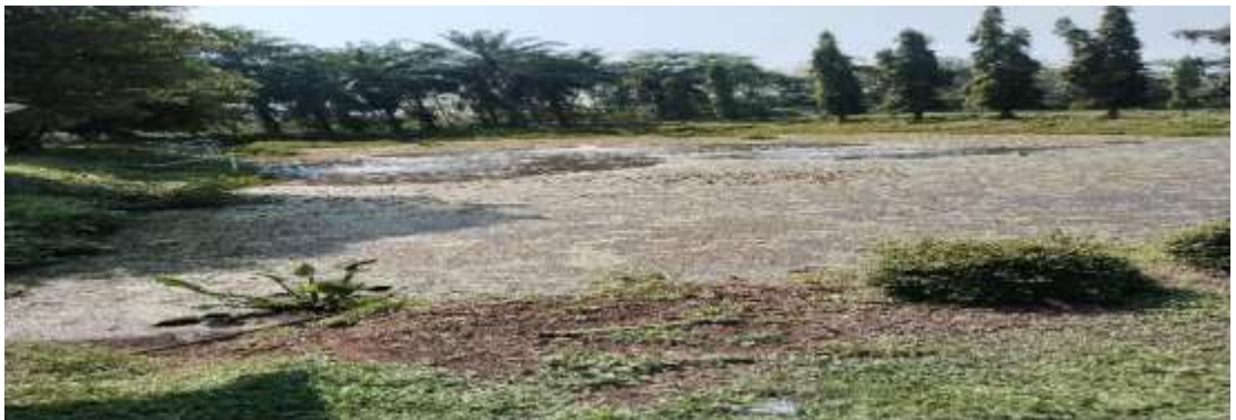
Gambar 1.6 bak penampungan aerob I
